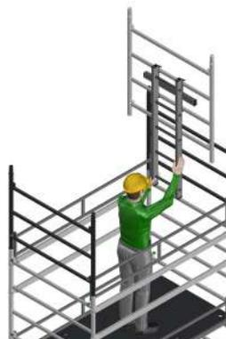
Saturno<sup>Pro</sup> utilizza un innovativo sistema di montaggio attraverso la botola (ABL) che, in combinazione con lo strumento alza spalle ProTech permette il **montaggio del trabattello senza l'utilizzo di dispositivi anticaduta, in totale sicurezza e rispetto di UNI EN 1004-2.**
